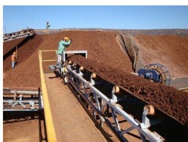
Montagem das Pilhas de minério para lixiviação
