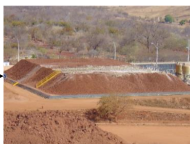
Pilhas de lixiviação de 4m de altura sobre piso impermeabilizado
