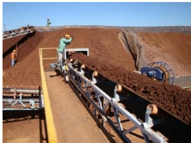
Minério aglomerado (úmido) sendo transportado para montagem de Pilhas de lixiviação na Planta de Testes
